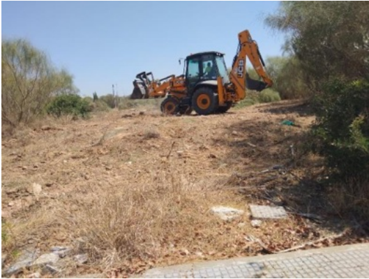
Foto 1: Desbroce mecánico de vegetación I.
