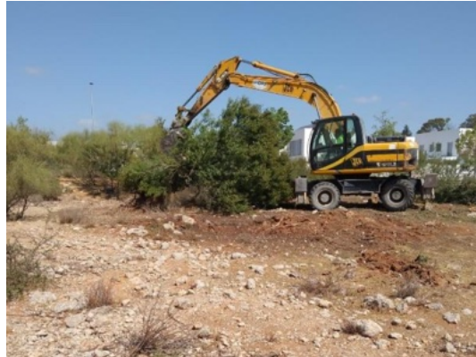
Foto 2: Desbroce mecánico de vegetación II.
